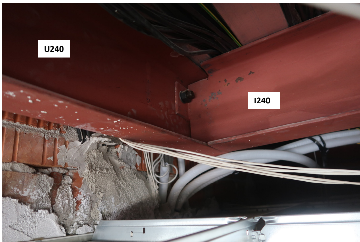
Obr. 16: Detail výměny při nároží výtahové šachty – připojení stropnice k výměně průvzlaku
