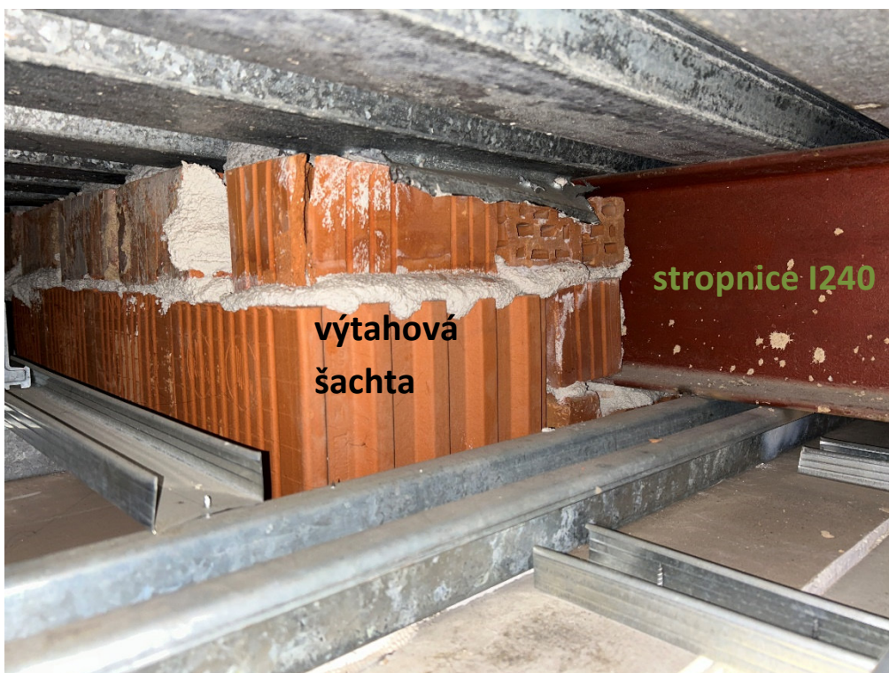
Obr. 3: Dokumentace sondy S2 – uložení stropnice na výťahovou šachtu
