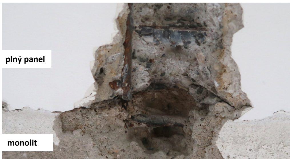
Obr. 20: Výztuž v sondě – plný panel a monolit
