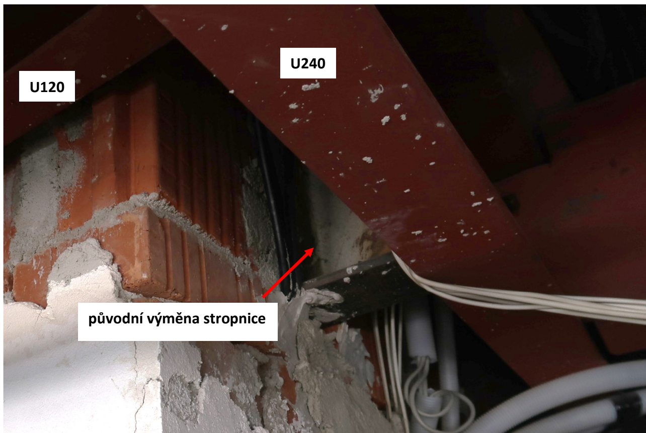
Obr. 17: Detail výměny při nároží výtahové šachty – přípoj výměny průvzlaku k výtahové šachtě
