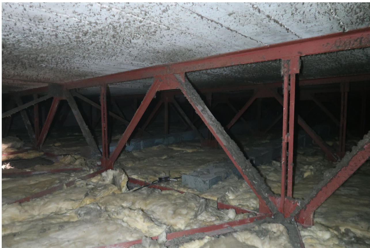
Obr. 9: Začátek vedení VZT v podstřeší
