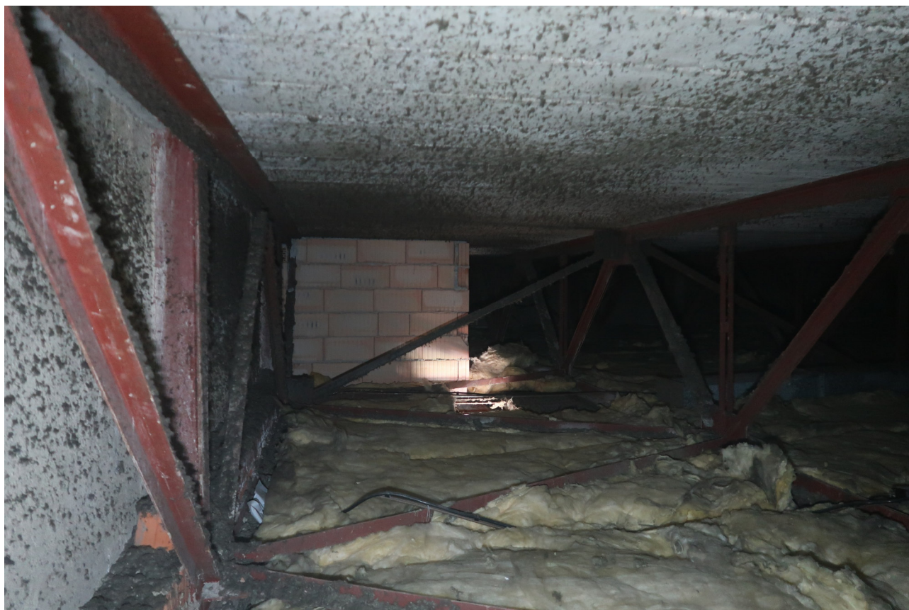
Obr. 11: Vodorovná a šikmá ztužidla před výtahovou šachtou
