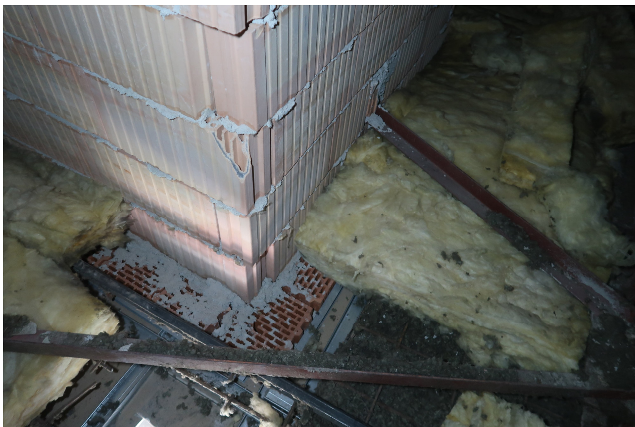
Obr. 12: Vodorovná ztužidla před výtahovou šachtou
