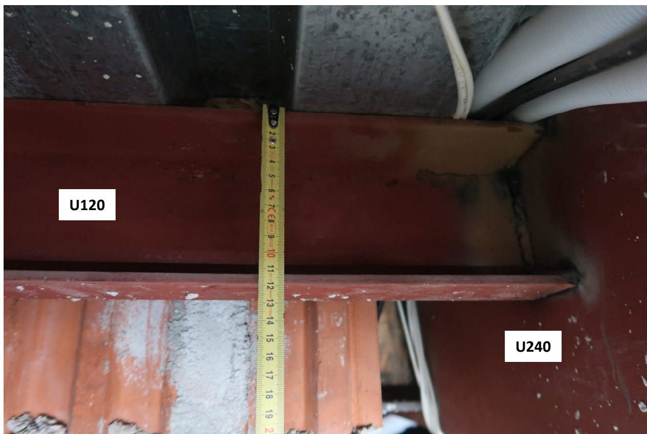
Obr. 15: Detail výměny při nároží výtahové šachty
