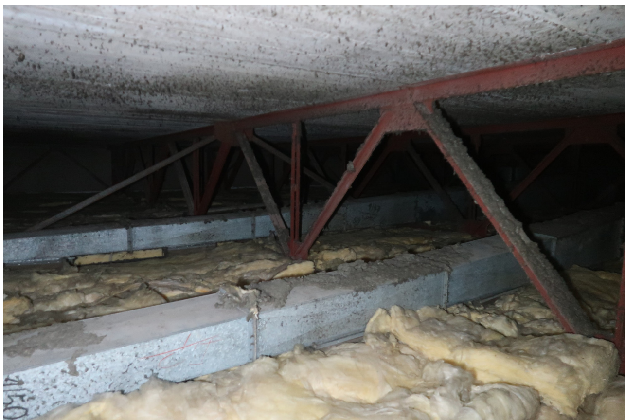
Obr. 10: Průchod VZT vazníkem v podstřeší
